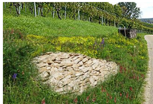
Neu: Böschung mit Steinlinsen
